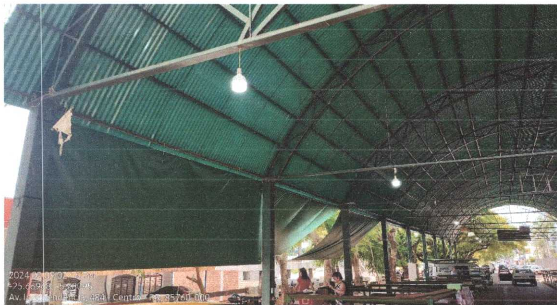
Foto 32 – Cortinas-toldos da rua coberta
