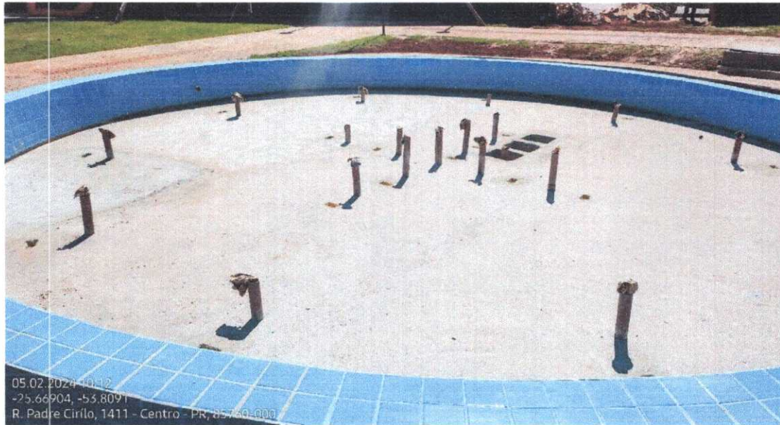
Foto 07 – Fundo do chafariz necessita de um acabamento liso
