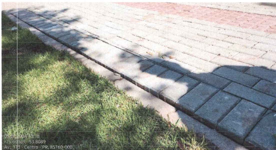
Foto 08 – Paver com afundamento
