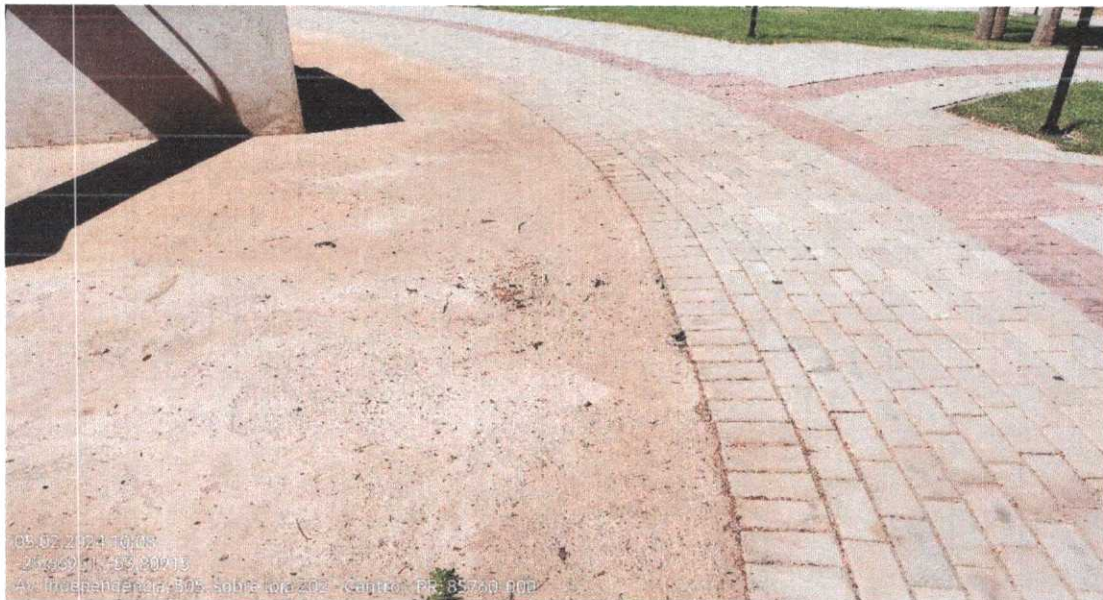
Foto 04 – Área de acúmulo de água pluvial
